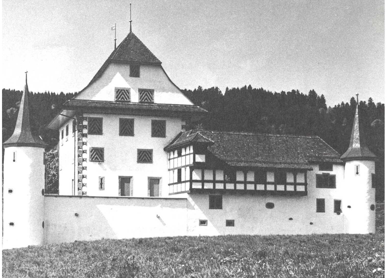
Schloss Wyher nach der Aussenrenovation – von Osten gesehen.
