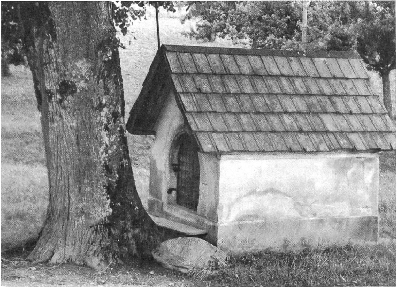
Das Siebenschläfer-Chäppali vor der Restauration.
