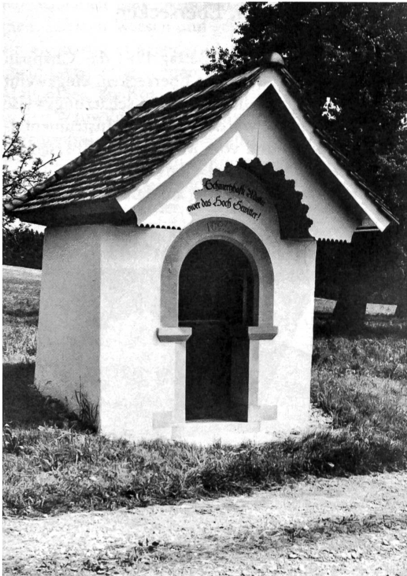
Sein Aussehen heute. Die Schäden wurden behooben und unschickliche Zutaten entfernt.
