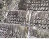
Figure 1: Vue amont du barrage de Deriner et stabilisation des appuis par ancrages.
