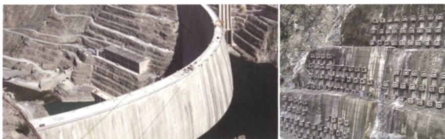
Figure 1 : Vue amont du barrage de Deriner et stabilisation des appuis par ancrages.
