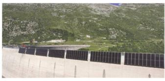
Figure 4: Centrale DMPV sur le barrage de Valle di Lei (© ewz).
