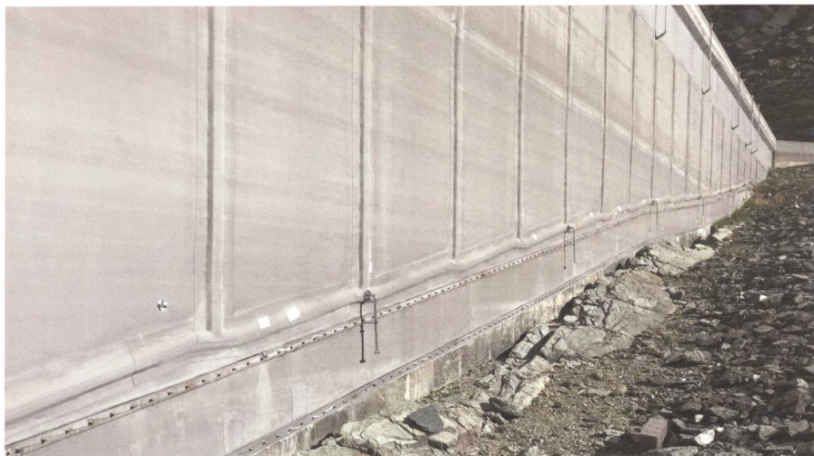
Bild 5: Dichtungsmembrane auf dem wasserseitigen Parament der Staumauer Illsee, Details des Anschlusses am Mauerfuss.
