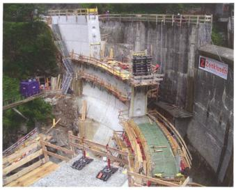
Bild 3: Bau der neuen Staumauer Sera gleich luftseitig der bestehenden Sperre.
