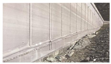
Bild 5: Dichtungsmembrane auf dem wasserseitigen Parament der Staumauer Illsee, Details des Anschlusses am Mauerfuss.
