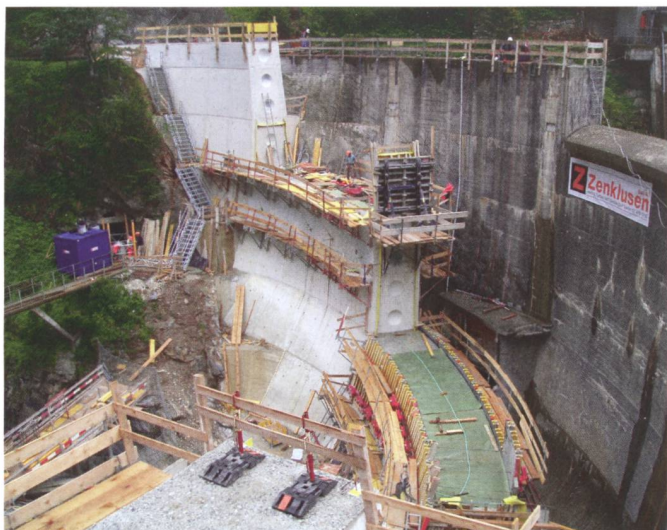
Bild 3: Bau der neuen Staumauer Sera gleich luftseitig der bestehenden Sperre.
