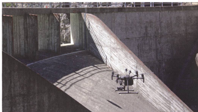
Bild 4: Drohneinsatz für Nahbereichsphotogrammetrie einer Staumaueroberfläche (Bild: Schneider Ingenieure AG).
