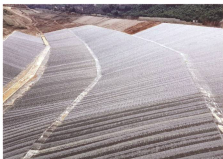
Figure 10: Exemple de réaménagement de la pente d'un réservoir et de l'installation d'un revêtement en géomembrane pour prévenir les pertes d'eau dans des formations rocheuses karstiques et fissurées (Moyen Orient).
