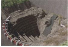
Figure 7: Barrage de Kariba, Zambie/Zimbabwe – Vue des travaux en cours sur le bassin de dissipation d'énergie dans la zone d'érosion (mars 2023) et vue d'une image de synthèse de l'excavation à la fin des travaux (Razel Bec, 2016).
