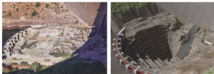
Figure 7: Barrage de Kariba, Zambie/Zimbabwe – Vue des travaux en cours sur le bassin de dissipation d'énergie dans la zone d'érosion (mars 2023) et vue d'une image de synthèse de l'excavation à la fin des travaux (Razel Bec, 2016).
