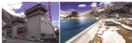
Bild 14: Zentraler Mauerblock der Staumauer Muttsee während den Betonarbeiten/Fertiggestellte Staumauer Muttsee beim Erstaufstau.
