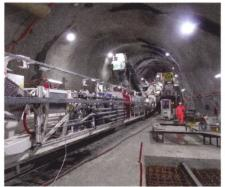
Bild 25: TBM-Montagekaverne mit montierter Tunnelbohrmaschine vor
