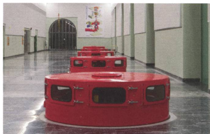
Bild 8: Maschinensaal der Zentrale Robièi mit den 4 neuen vertikalen reversiblen Francis-Pumpenturbinen à 40 MW und einer vertikalen Francis-turbine à 25 MW Leistung (OFIMA).
