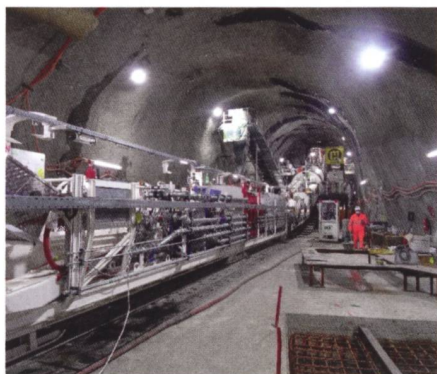
Bild 25: TBM-Montagekaverne mit montierter Tunnelbohrmaschine vor dem Ausbruch des Schrägschachtes.
