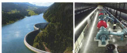
Bild 11: Stausee Hongrin mit doppelter Bogenstaumauer (links) und Ansicht des bestehenden 170 m langen Kavernenkraftwerks Veytaux I (alpiq.ch).
