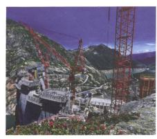
Bild 21: Erhöhung der Staumauer Vieux Émosson (PSW Nant de Drance).
