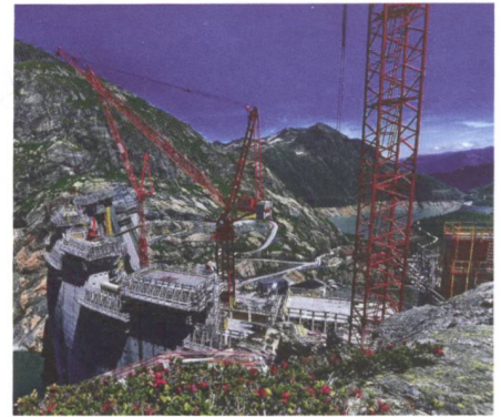
Bild 21: Erhöhung der Staumauer Vieux Émossion (PSW Nant de Drance).
