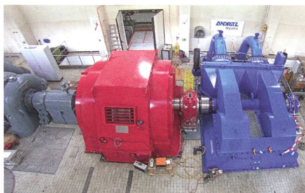
Bild 7: Erneuerung Zentrale Mottec mit der ternären Maschinengruppe 2 – best. Speicherpumpe, Kupplung, neuer Generator/Motor und neue 2-düsige Zwillings-Peltonturbine (FM Goug-ra).
