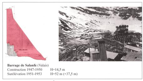
Figure 5: Barrage de Salanfe. À droite, photo du barrage première étape, H=14,5 m.
