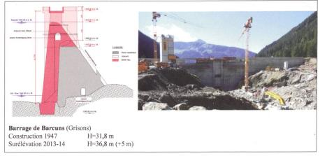
Figure 3: Barrage de Barcuns, avec vue des travaux de surélévation du côté amont de l'ouvrage.
