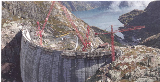
Figure 12: Nant de Drance – surélévation du barrage de Vieux-Émosson – réservoir supérieur.
