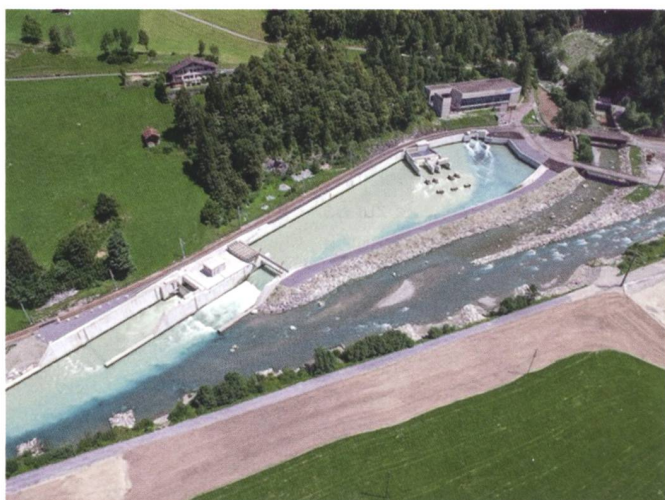
Bild 12: Schwall-Beruhigungsbecken Innertkirchen (BE) der Kraftwerke Oberhasli KWO (Quelle: KWO AG).
