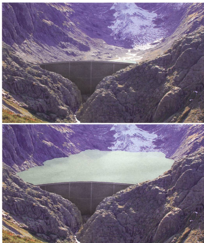
Figure 11 : Photomontages du futur barrage de Trift, d'une hauteur de 180 m, qui utilise la vallée déjà libérée par le retrait du glacier. En-haut : à lac vide avec position du glacier en 2015. En-bas : à lac plein (Photo KWO).
