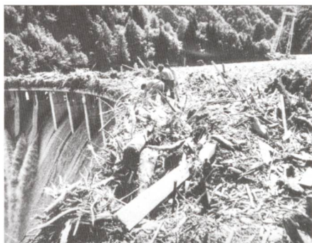
Figure 10: Obstruction des passes du barrage de Palagnedra (TI) lors de la crue du 7 août 1978.
