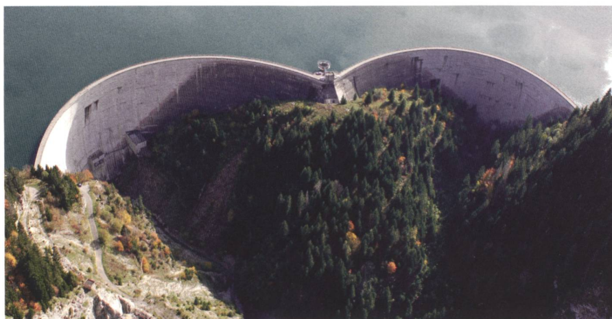
Figure 5: Les barrages voûtes de l'Hongrin (H=125/90 m).
