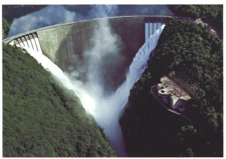
Figure 6: Le barrage voûte de Contra (H=220 m).
