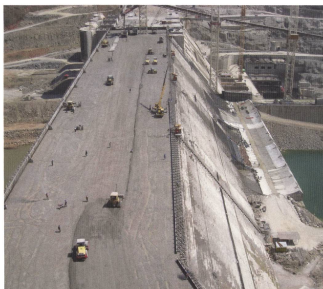
Figure 7: Construction du barrage en BCR de Yeywa au Myanmar (MOEE).
