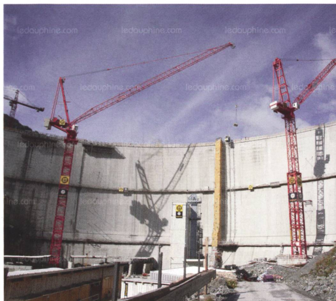
Figure 2: Surélévation du barrage de Vieux Émosson d'Alpiq (VS).
