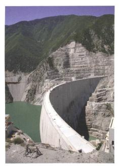
Figure 5: Barrage voûte de Deriner (H=253 m) sur le Çoruh (DSI/Turquie).
