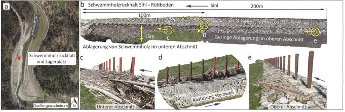
Bild 2: Übersicht des Schwemmholzrechens an der Sihl (a) und das mittels SfM-Photogrammetrie erzeugte 3D-Modell (b) bis (e). Die gelben Markierungen in (b) zeigen die Position und Blickrichtung der Bildausschnitte in (c) bis (e).
