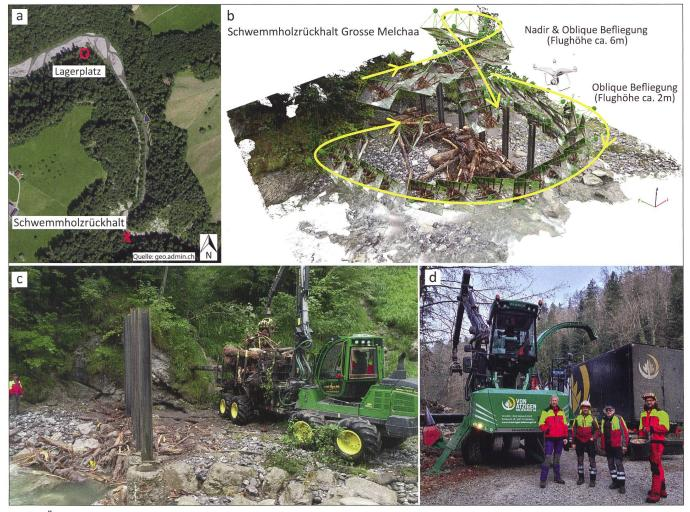
Bild 1: Übersicht des Schwemmholzrückhalts an der Grossen Melchaa im Kanton Obwalden (a) und der Drohnenbefliegung für Structure-from-Motion-Photogrammetrie der Schwemmholzverklausung (b). Die grünen Rechtecke entlang der gelben Flugtrajektorie in (b) zeigen die Kameraperspektiven und -positionen während der Datenaufnahme. Zur Räumung (c) und Analyse (d) der Schwemmholzansammlung war der Einsatz von schwerem Gerät erforderlich.
