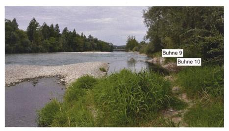
Bild 19: Während der hohen Abflüsse im Sommer 2021 wurde viel Geschiebe umgelagert. Anhand der Geschiebeablagerung vor den Buhnen 9 und 10 wurde ersichtlich, dass eine beträchtliche Geschiebemenge durch den Seitenarm transportiert wurde. Die Buhnen 9 und 10 wurden vorübergehend nicht mehr angeströmt. Aufnahme vom September 2021, Blick in Fliessrichtung.
