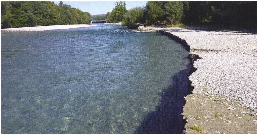
Bild 10: Frischer Uferabbruch bei einem Abfluss von 60\text{m}^3/\text{s} vor dem Bau der Buhnen. Blick in Fliessrichtung.
