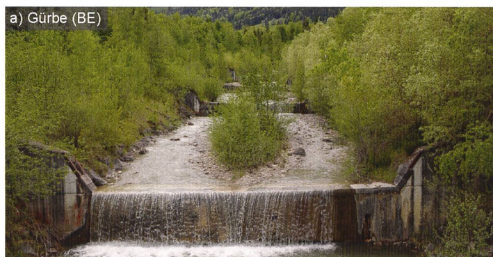
Figure 1 : a) Barrages dans la Gürbe (BE) avec S=0,07 (photo: SWV, 2021); b) séquence seuil-mouille construite dans le Betelriedbach (BE) avec S=0,15 (photo: VAW).
