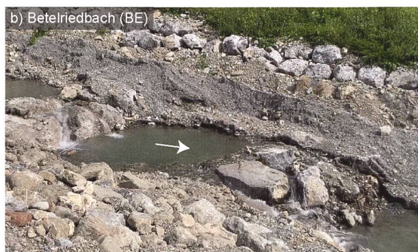
Figure 1 : a) Barrages dans la Gürbe (BE) avec S=0,07 (photo: SWV, 2021); b) séquence seuil-mouille construite dans le Betelriedbach (BE) avec S=0,15 (photo: VAW).
