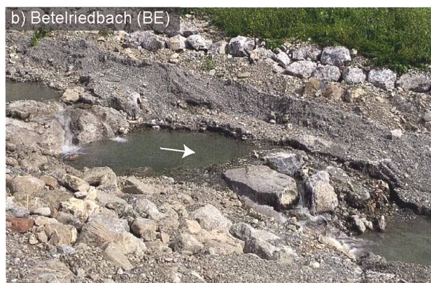
Bild 1: a) Wildbachsperren in der Gürbe (BE) mit S=0,07 (Foto: SWV, 2021); b) Gebaute Stufen-Becken-Abfolge im Betelriedbach (BE) mit S=0,15 (Foto: VAW).
