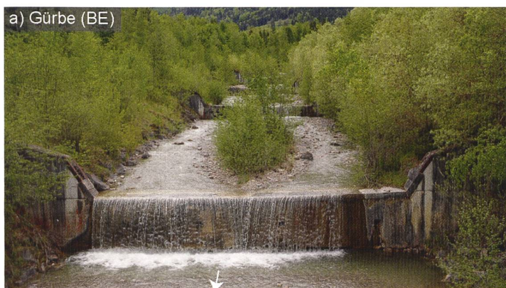
Bild 1: a) Wildbachsperren in der Gürbe (BE) mit S=0,07 (Foto: SWV, 2021); b) Gebaute Stufen-Becken-Abfolge im Betelriedbach (BE) mit S=0,15 (Foto: VAW).
