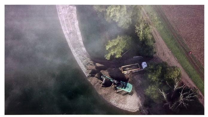
Eine mögliche Massnahme zur Sanierung des Geschiebehaushalts: Kiesentnahme oberhalb des Stauwehrs und Verlad auf LKW für die anschliessende Schüttung im Unterwasser. Kraftwerk Bremgarten-Zufikon an der Reuss. Foto: Carlos R. Wyss.
