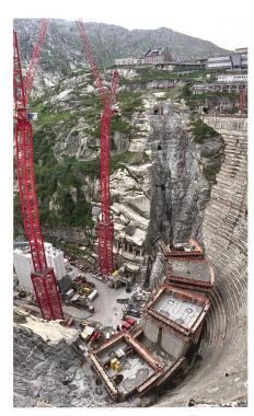
Bild 2: Blick auf die ersten im Bau stehenden Betonblöcke der neuen Bogenmauer Spitallamm.
