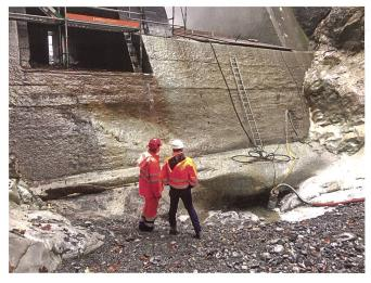
Bild 20: Dammfuss mit Abrasionserscheinungen am Wehrbeton sowie Auskolkungen. Oben rechts ist der Auslauf der Hauptund Regulierschütze, oben links der Auslauf der beiden Grundablässe zu erkennen.
