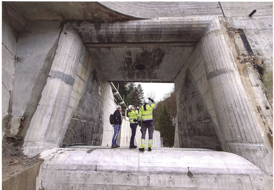
Bild 14: Vergrösserte Wehröffnung bei abgelegter Stauklappe mit ausgerundetem Zuströmbereich, Belüftungsschlitz an der Brückenuntersicht und Parapet auf der Mauerkrone (Blick Richtung Unterwasser).
