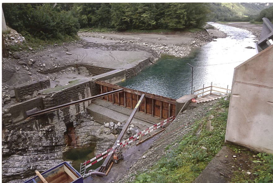
Bild 9: Bauwand im Oberwasser des Stauwehrs Schlattli auf der Schwelle der alten Wasserfassung zur Umleitung der Muota durch den Umleitstollen (Aufnahme während des Einstauversuchs).
