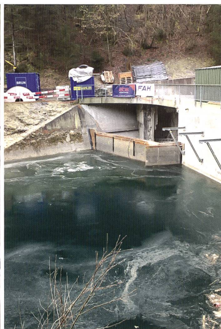
Bild 11: Bauwand oberwasserseitig vor Stauklappe, links ohne, rechts mit Einstau.
