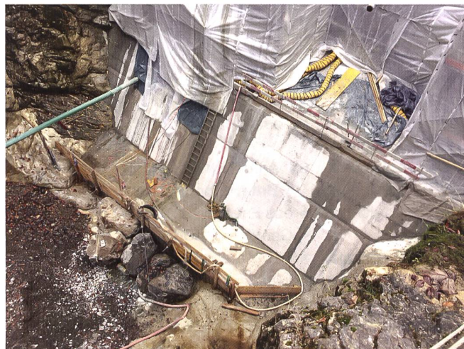
Bild 21: Neue Verschleisschicht unter den Ausläufen der Haupt- und Regulierschütze und der Grundablässe, neuer Vorbeton am Dammfuss sowie Blöcke als Kolkenschutz.
