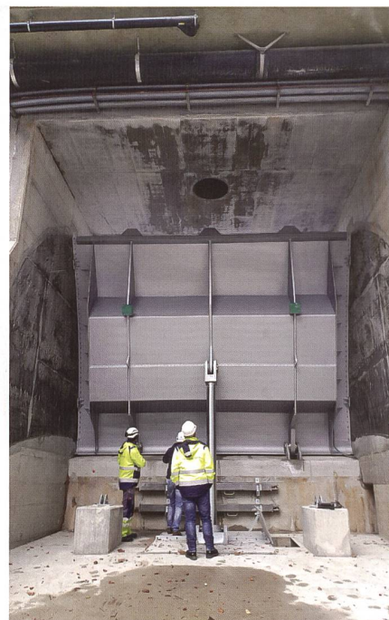
Bild 17: Vollständig angehobene Stauklappe (Blick Richtung Oberwasser).
