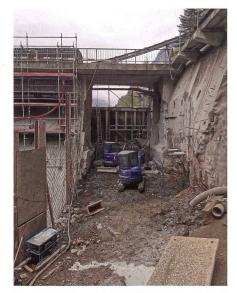
Bild 13: Betonabbruch/Felsausbruch mit Kleinbagger und Abbauhammer im Stauklappenbereich. Im Hintergrund ist die Bauwand zu erkennen (Blick Richtung Oberwasser).
