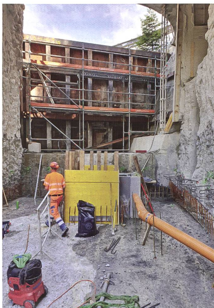
Bild 10: Errichtung des Zylinderschachtes und des Schwellenriegels im Schutz der Bauwand (Blick Richtung Oberwasser).
