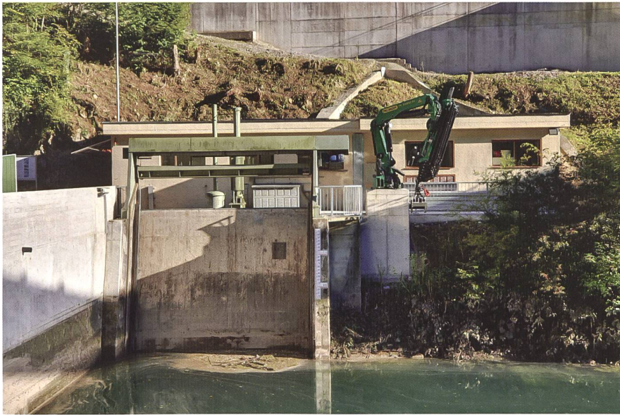
Bild 19: Rechenanlage beim Einlauf zum Druckstollen (links) mit neuem Schwemmholzkran inkl. Fundament (rechts) vor dem Betriebsgebäude.
