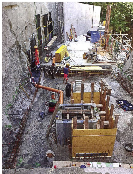
Bild 15: Betonarbeiten an der Entlastungsrinne und dem Zylinderschacht im Bereich der Stauklappenverankerung (Blick Richtung Unterwasser).
