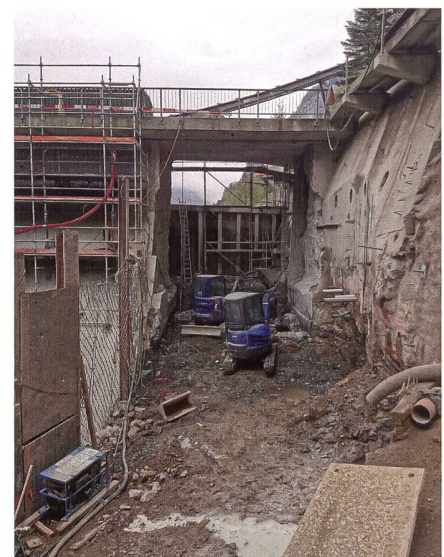
Bild 13: Betonabbruch/Felsausbruch mit Kleinbagger und Abbauhammer im Stauklappenbereich. Im Hintergrund ist die Bauwand zu erkennen (Blick Richtung Oberwasser).
