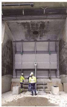
Bild 17: Vollständig angehobene Stauklappe (Blick Richtung Oberwasser).
