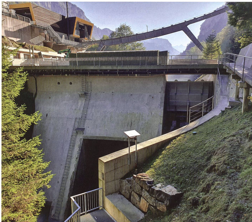
Bild 22: Unterwasserseite Stauwehr Schlattli nach Abschluss der Bauarbeiten. Im Vordergrund ist die Leitwand der Entlastungsrinne mit neuer Sickerwassermessstelle, rechts dahinter die neue Stauklappe erkennbar.
