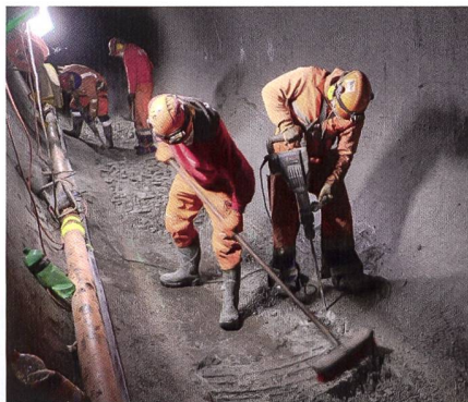
Stollensanierung im Kraftwerk Göschenen. Bild: CKW.
