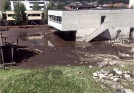
Bild 9: In Giubiasco (Gemeinde Bellinzona TI) führte am 7. August 2021 das Versagen einer seitlichen Mauer des Rückhaltebeckens des Riale Fossato (links) zur grossräumigen Überschwemmung eines Schulareals (rechts) (Foto: Ufficio dei corsi d'acqua, Dipartimento del territorio, TI).
