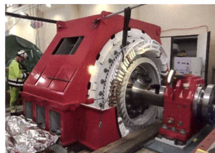
Montage d'un nouvel alternateur à Mottec.
