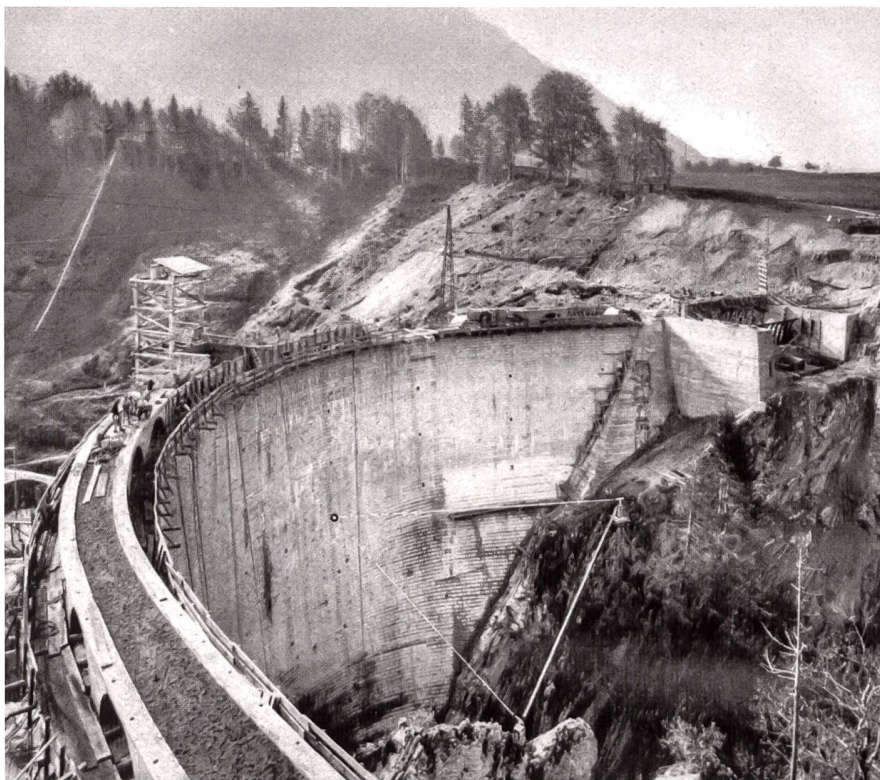
Bild 3: Staumauer Montsalvens kurz vor Bauabschluss mit den zwei Pfeilern und dem Beispiel eines Vorwärtseinschnittes auf einen Mauerbolzen (Lang 1929).
