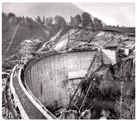
Bild 3: Staumauer Montsalvens kurz vor Bauabschluss mit den zwei Pfeilern und dem Beispiel eines Vorwärtseinschnittes auf einen Mauerbolzen (Lang 1929).
