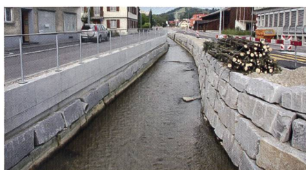
Bild 13: Entwicklung eines Niederwassergerinnes mit Instream-Massnahmen. (Fotos: Kt. LU, vif, Abt. Naturgefahren).
