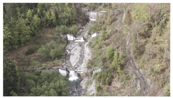
Stark beschädigte Sperren im Gebiet der Meierisli-Rutschung. Die unterste Sperre 33 ist im Bild unten auf Seite 173 im Detail zu sehen. Foto: Jürg Speerli.
