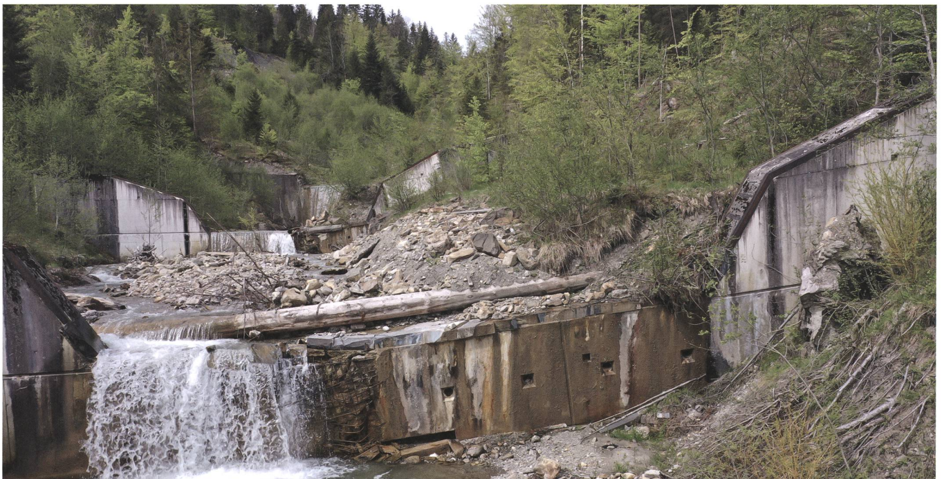
Detailansicht der starken Beschädigungen an der Sperre 33. Die Sperre ist stark verkippt und weist grosse Betonabplatzungen auf. Foto: Jürg Speerli.
