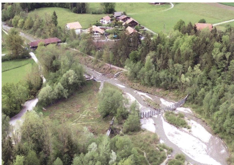
Luftaufnahme des unteren Teils der Ausschütte mit dem Schwemmholtzrückhaltebauwerk. Links vom Schwemmholtzrückhaltebauwerk befindet sich die Tauchwand, welche im Überlastfall überströmt werden kann. Foto: Jürg Speerli.
