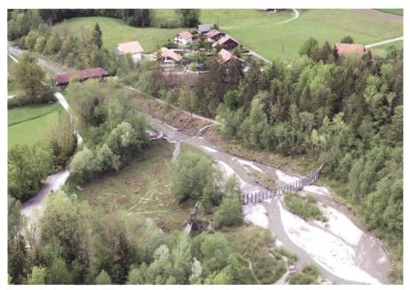
Luftaufnahme des unteren Teils der Ausschütte mit dem Schwemmholzrückhaltebauwerk. Links vom Schwemmholzrückhaltebauwerk befindet sich die Tauchwand, welche im Überlastfall überströmt werden kann. Foto: Jürg Speerli.
