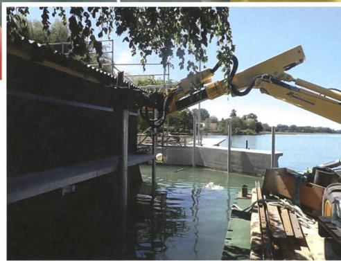
Bei Sanierungen von Ufermauern und anderen unterspülten Bauwerken steht das Team des Unternehmens TAF Taucharbeiten AG mit Gewebeschalungen oder Gewebecontainern im Einsatz. Sie werden mit einem speziellen Unterwasser-Beton «geimpft». Die Gewebe bestehen aus Chemie-Kunstfasern von hoher Reißfestigkeit. Für Beton undurchlässig, schützen sie diesen während der Aushärtungsphase vor Auswaschungen.
