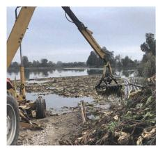
Bild 3: Die gemähten Teichrosen und abgerechten Rhizome werden bei der Einwasserungsstelle aus dem See entfernt und direkt daneben gelagert.
