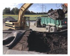
Bild 8: Das entwässerte Sediment wird direkt aus den Geotubes für die landwirtschaftliche Verwertung aufgeladen.
