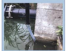
Belüftungsrohr der Hebersteuerung, im Hintergrund Tiefenwasserableitung.
