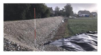
Bild 4: Entwässerungsgraben und Randdamm des Entwässerungsplatzes vor Einbringen der Abdichtung.
