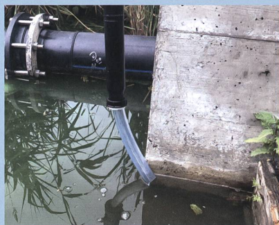
Belüftungsrohr der Hebersteuerung, im Hintergrund Tiefenwasserableitung.
