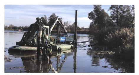
Bild 2: Der schwimmende Saugbagger entfernt die oberste Schicht des Sediments durch den am Hebelarm befestigten Saugkopf (nicht erkennbar im Wasser). Rechts hinter dem Saugbagger ist die Leitung erkennbar, durch welche das Sediment zum Entwässerungsplatz gepumpt wird.
