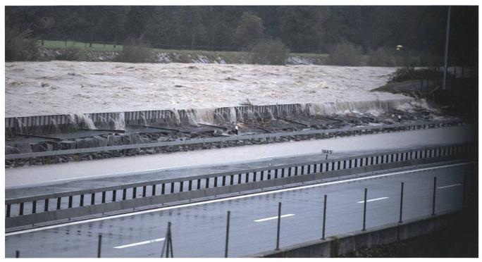
Bild 8: Die hochgehende Reuss wurde am 3. Oktober über die Entlastungsanlage bei Altdorf auf die Autobahn A2 abgeleitet. (Foto: Valentin Luthiger).
