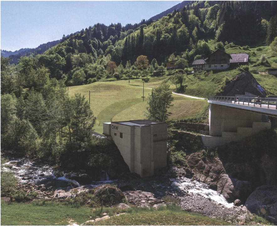
Visualisierung der Kraftwerkszentrale unterhalb der Chrutacherbrücke in Flühli. Ab hier fliesst das entnommene Wasser zurück in die Waldemme und durch die Lammschlucht. Foto: CKW.
