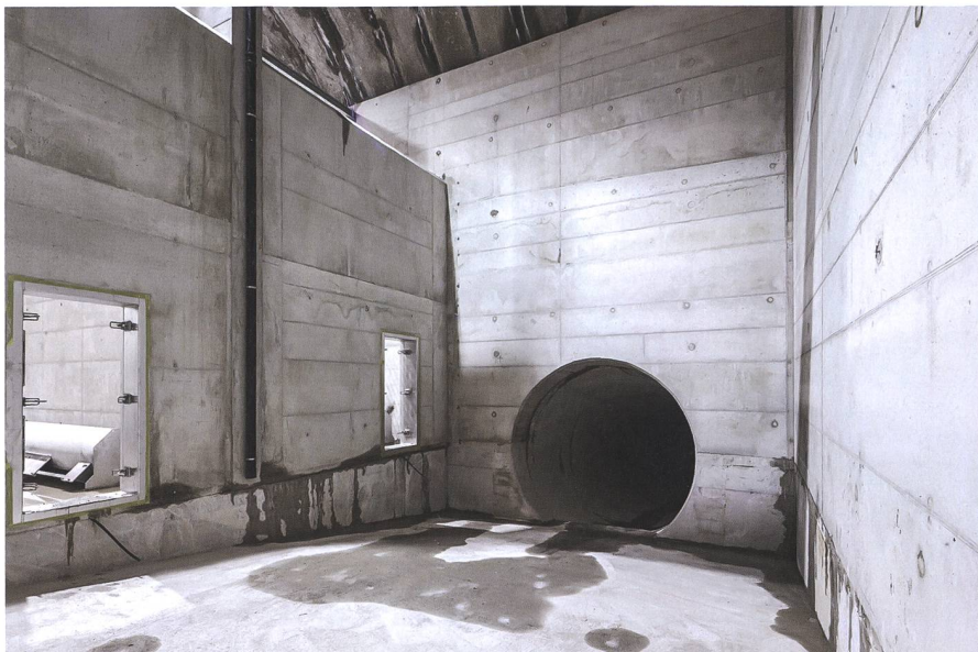
Bild 3: Blick in die Druckaufbaukammer: Rechts hinten beginnt der Druckstollen, durch den das Wasser zum Kraftwerk gelangt. Die Durchgänge links führen ins Entsanderbecken (Foto aus der Bauzeit). Im Entsanderbecken lagern sich die Sedimente ab, die die Rhone vor allem im Frühjahr in grossen Mengen heranträgt. Foto: FMV.
