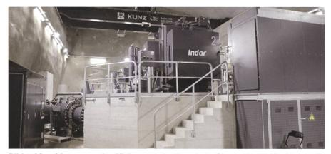
Bild 1: Maschinenraum des Kleinwasserkraftwerks in Oberwald: Die Turbinen mit  $2 \times 7,5 \,\text{MW}$  Leistung sind auf die Maximalproduktion im Sommer ausgelegt. Zum Vergleich: Die fünf Windräder, die im Herbst 2020 auf dem Gotthard in Betrieb genommen wurden, haben eine Nennleistung von  $5 \times 2,35 \,\text{MW}$ . Foto: FMV.
