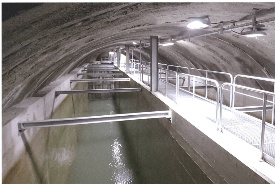
Bild 4: Die Entsanderkaverne, zur Hälfte entleert. Foto: FMV.
