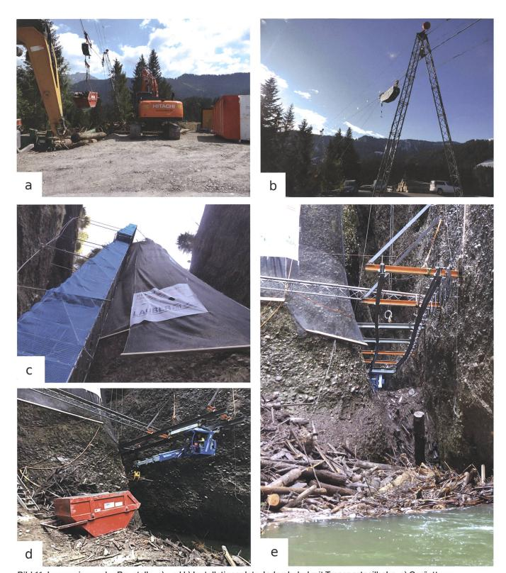
Bild 11: Impressionen der Baustelle, a) und b) Installationsplatz Jodershubel mit Transportseilbahn, c) Gerüstturm, d) Schienenkran beim Beladen der Mulden, e) beidseitig verankerte Schienen in der verwundenen Schlucht.
