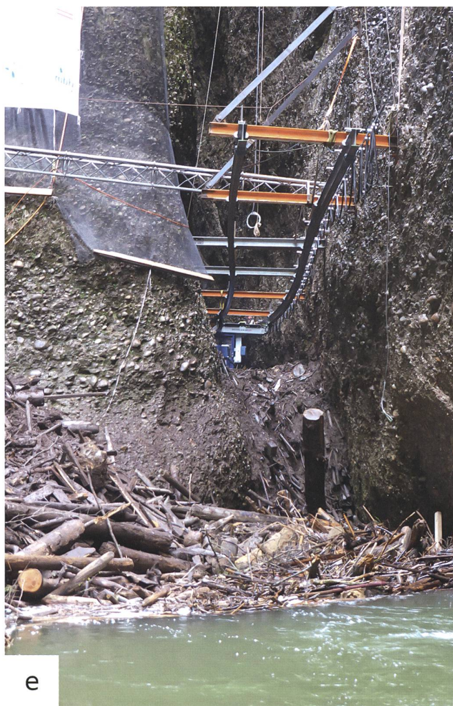
Bild 11: Impressionen der Baustelle, a) und b) Installationsplatz Jodershubel mit Transportseilbahn, c) Gerüstturm, d) Schienenkran beim Beladen der Mulden, e) beidseitig verankerte Schienen in der verwundenen Schlucht.
