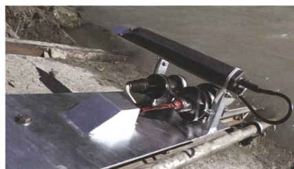
Bild 4: Hydrologische Station Aare-Brienzwiler; Messanlage mit zwei optischen Sonden und einer akustischen Sonde. Foto: D. Lussi, METAS.
