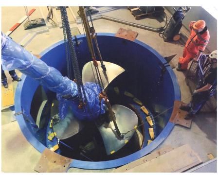
Bild 10: Montagevorgang bei einer Kaplan-Turbine bei vollkugeligem Laufradmantel (Foto: EKZ).
