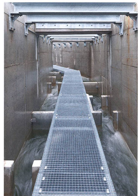
Bild 3: enature®-Fischaufstiegshilfe beim Dotierkraftwerk (Foto: EKZ).
