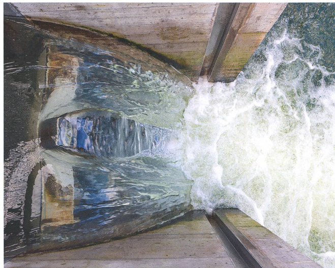
Bild 9: Bypassauslauf ins Unterwasser mit überströmter Stauklappe (Foto: EKZ).
