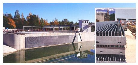
Bild 5: Einlaufrechen DKW vor dem Fluten des Oberwasserkanals (Foto: EKZ).
