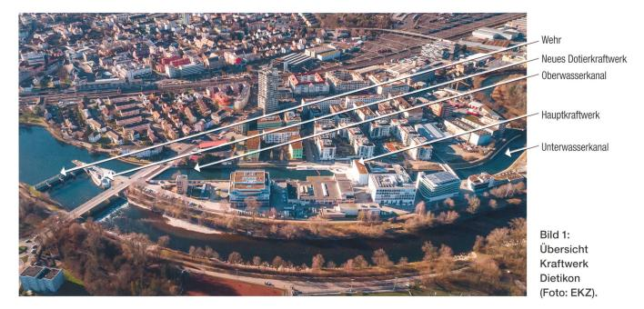
Fassungsvermögens des bestehenden Oberwasserkanals wurde eine Aufteilung von 95 m³/s Ausbauwassermenge beim Hauptkraftwerk und 25 m³/s beim neuen Dotierkraftwerk gewählt.
