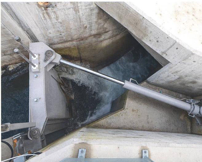
Bild 8: Stemmtor beim Bypasseinstieg für den Fischabstieg HKW (Foto: EKZ).
