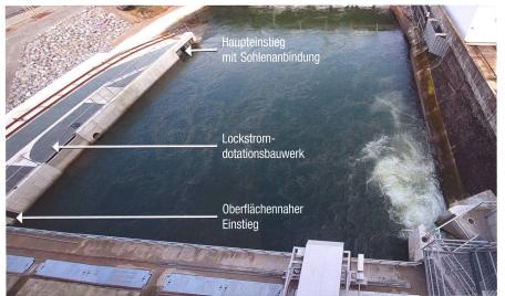
Bild 4: Einstiegssituation Fischaufstieg beim Hauptkraftwerk (Foto: EKZ).
