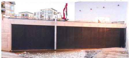
Bild 6: Horizontalrechen HKW vor der Kanalflutung (Foto: EKZ).
