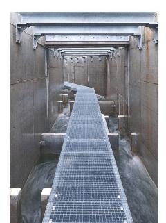
Bild 3: enature®-Fischaufstiegshilfe beim Dotierkraftwerk (Foto: EKZ).
