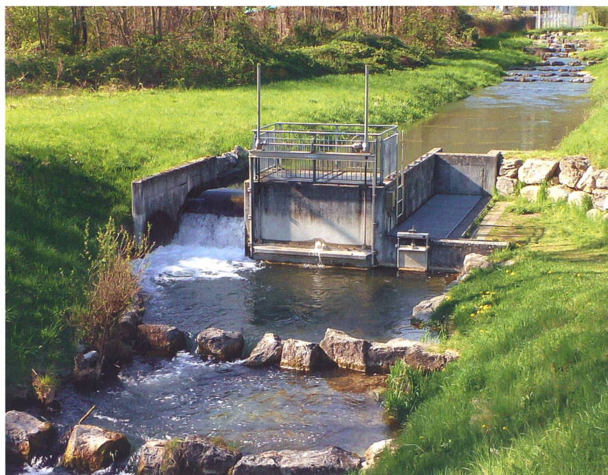
Bild 2: Zählbecken Winznau im Betriebszustand. Bei geschlossenem Schütz (Mitte) strömt das Wasser über den Überfall (links) und durch das Zählbecken (rechts).
