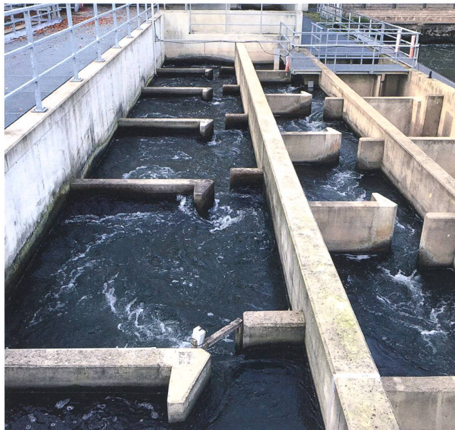
Figure 8: A gauche: schéma d'écoulement dans une passe à méandres de type C (exemple: Birse/Courrendlin JU; photo: J. Stork); à droite: schéma d'écoulement («dissipation d'énergie» – côté gauche et «écoulement stable» – côté droite, selon DWA 2014) dans une passe à fentes verticales (exemple: Moselle/Coblence, Rhénanie-Palatinat; photo: M. Mende).
