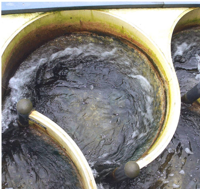
Figure 8: A gauche: schéma d'écoulement dans une passe à méandres de type C (exemple: Birse/Courrendlin JU; photo: J. Stork); à droite: schéma d'écoulement («dissipation d'énergie» – côté gauche et «écoulement stable» – côté droite, selon DWA 2014) dans une passe à fentes verticales (exemple: Moselle/Coblence, Rhénanie-Palatinat; photo: M. Mende).
