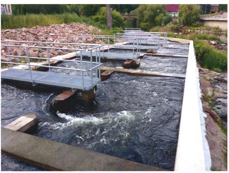
Figure 6: Passe à fentes verticales avec bassins alternés (photo: www.ibhandrick.de).
