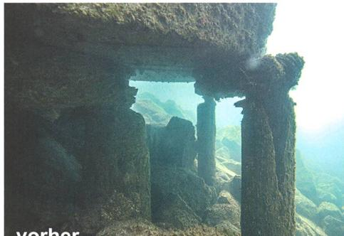
Bei Sanierungen von Ufermauern und anderen unterspülten Bauwerken steht das Team des Unternehmens TAF Taucharbeiten AG mit Gewebeschalungen oder Gewebecontainern im Einsatz. Sie werden mit einem speziellen Unterwasser-Beton «geimpft». Die Gewebe bestehen aus Chemie-Kunstfasern von hoher Reissfestigkeit. Für Beton undurchlässig, schützen sie diesen während der Aushärtungsphase vor Auswaschungen. Die Vorteile der Gewebeschalungen sind:
