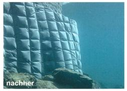
Bei Sanierungen von Ufermauern und anderen unterspülten Bauwerken steht das Team des Unternehmens TAF Taucharbeiten AG mit Gewebeschalungen oder Gewebecontainern im Einsatz. Sie werden mit einem speziellen Unterwasser-Beton «geimpft». Die Gewebe bestehen aus Chemie-Kunstfasern von hoher Reissfestigkeit. Für Beton undurchlässig, schützen sie diesen während der Aushärtungsphase vor Auswaschungen. Die Vorteile der Gewebeschalungen sind:
