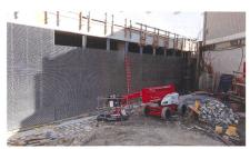
Bild 7: Das Limmat-Kraftwerk in Dietikon (ZH) verfügt seit dem vergangenen Jahr über den grössten Horizontalrechen in der Schweiz mit einer Rechenfläche von über 200 m² und einem Stababstand von 20 mm. Das Foto wurde im August 2019 aufgenommen, kurz vor der Inbetriebnahme des Kraftwerks. Der Bypasseingang befindet sich rechts beim Baugerüst (Foto: Julian Meister/VAW).
