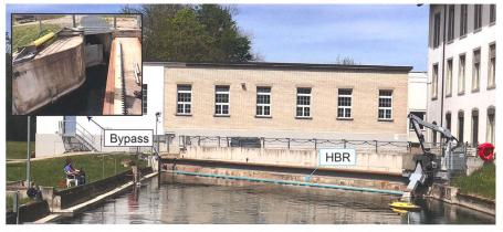
Bild 1: Das Laufwasserkraftwerke Stroppel in der Gemeinde Untersiggenthal (AG) ist mit einem horizontalen Fischleitrechen (HBR) ausgerüstet, der die in der Limmat lebenden Fische (u. a. Schneider, Barben und Rotaugen) in einen Bypass leitet, damit sie am Kraftwerk vorbei flussabwärts wandern können. Bei grösseren Laufwasserkraftwerken werden Fischleitrechen bisher in Europa nicht eingesetzt (Foto: Ismail Albayrak, VAW).
