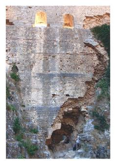
Bild 8: Luftseite der Staumauer mit den Hochwasserüberläufen (oben). Über den Resten des Grundablassgewölbes grosse Mauerausbrüche infolge hydrodynamischer Vorgänge im Grundablass. Oben rechts der Bogenrest der ehemaligen Aquäduktbrücke.
