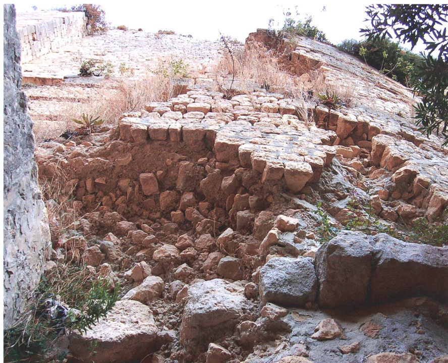
Bild 7: Beschädigte zylindrische Stauwand.
