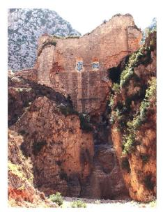
Bild 2: Das «Eiserne Tor» von Antiochia, unmittelbar über einer 35 m hohen Talstufe. In der Mitte die beiden Hochwasserüberläufe.
