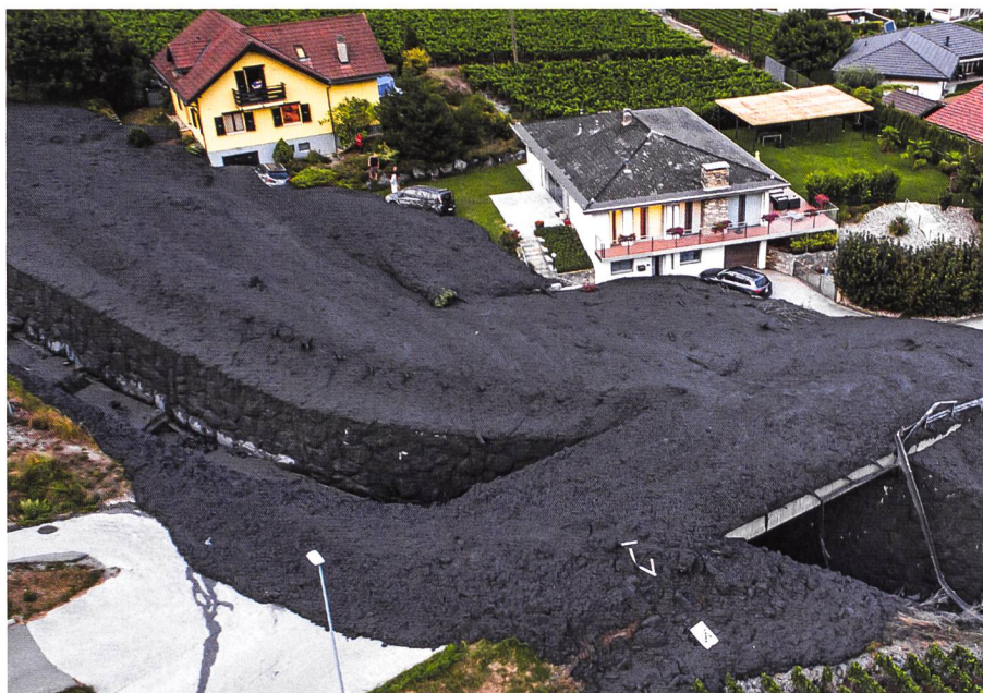
Bild 9. Am 7. August staute sich ein Murgang in Chamoson VS an mehreren Brücken (Foto: KEYSTONE / Maxime Schmid).
