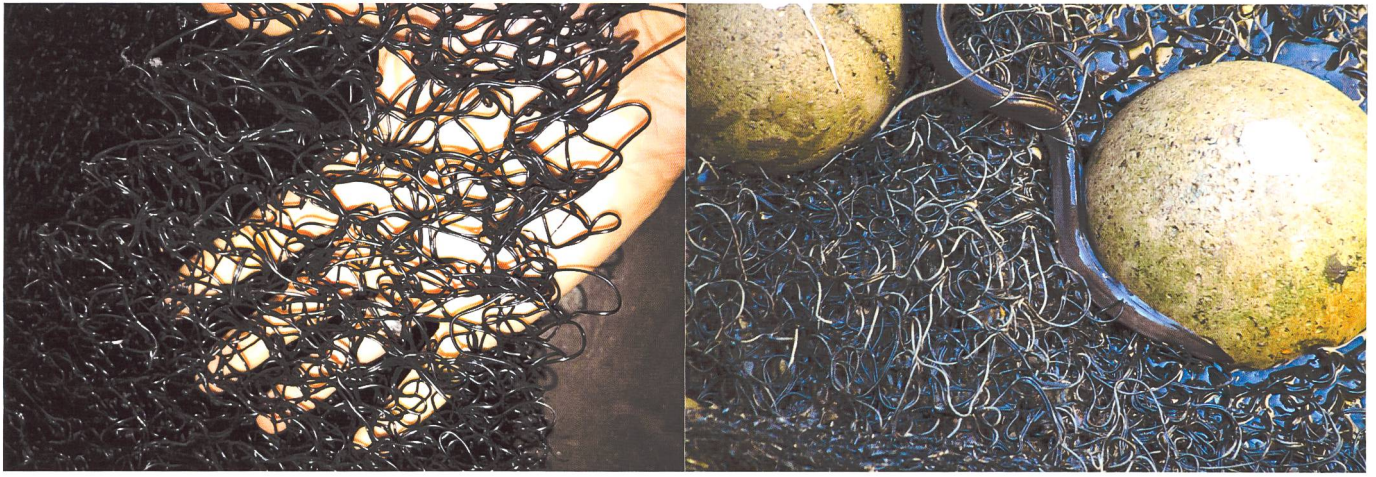
Bild 2: Links: Wirrgelegematte vor dem Einbau (Foto: M. Mende), rechts: Steiggaal auf Wirrgelegematte in trockengelegtem RBP (Foto: Hersteller).
