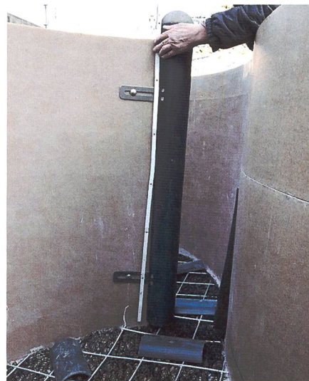
Bild 3: Links: Beckenanordnung und -gestaltung eines Typs C (im Bau), rechts: Gestaltung Schlitzöffnung (Rat'sches Wehr / Echaz, Reutlingen, Fotos: J. Stork).
