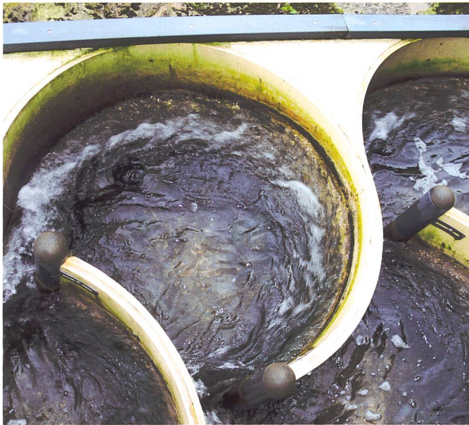
Bild 8: Links: Strömungsmuster in einem RBP Typ C (Beispiel: Birs / Courrendlin JU; Foto: J. Stork), rechts: Strömungsmuster («strömungsdissipierend» – linker Strang und «strömungsstabil» – rechter Strang, nach DWA, 2014) in einem konventionellen Schlitzpass (Beispiel: Mosel / Koblenz, Rheinland-Pfalz; Foto: M. Mende).
