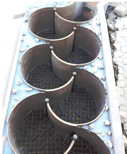
Bild 3: Links: Beckenanordnung und -gestaltung eines Typs C (im Bau), rechts: Gestaltung Schlitzöffnung (Rat'sches Wehr / Echaz, Reutlingen, Fotos: J. Stork).
