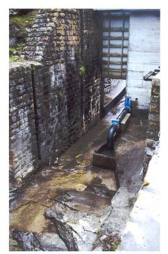
WF Puntalta, Tafelschütz Grundablass und Dotiereinrichtung.
