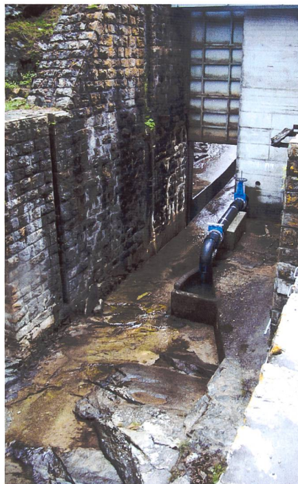
WF Puntalta, Tafelschütz Grundablass und Dotiereinrichtung.
