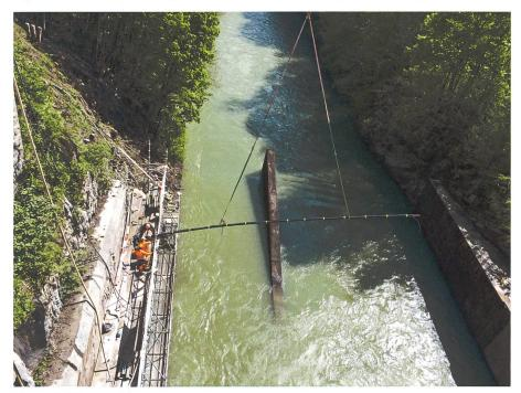
Figure 6. Mise en place d'un ancrage.
