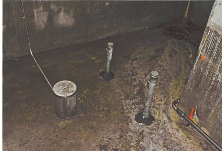
Figure 16. Drains et piézomètres dans le barrage.
