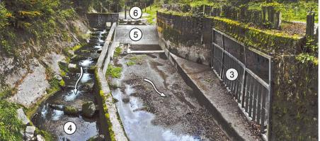
Bild 2. Bestehendes Verzweigungsbauwerk mit Einlauf zum Entlastungsstollen. Oben: Blick in Fliessrichtung; unten: Blick von der Staumauer gegen die Fliessrichtung.
