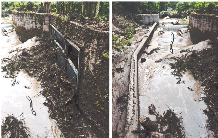
Bild 3. Links: Rechenverklausung beim Einlauf in den Stollen. Rechts: Auflandungen im Verzweigungsbauwerk (mod. nach oeko-b Fotodokumentation, 2015).
