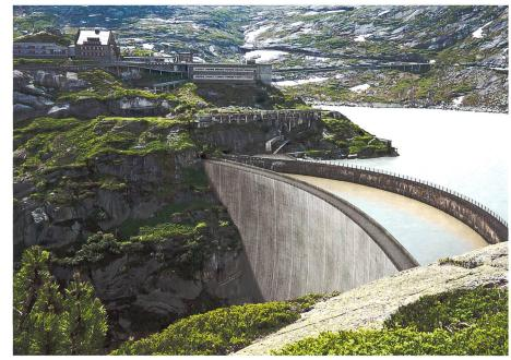
Visualisierung der vorgeschalteten neuen Mauer (Bild: KWO).
