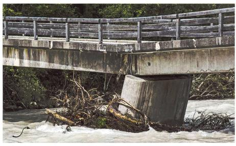
Bild 1. Verklausung an einem Brückenpfeiler und strukturelle Versagenswahrscheinlichkeit aufgrund von Kolk (Foto: bridgemastersinc.com).
