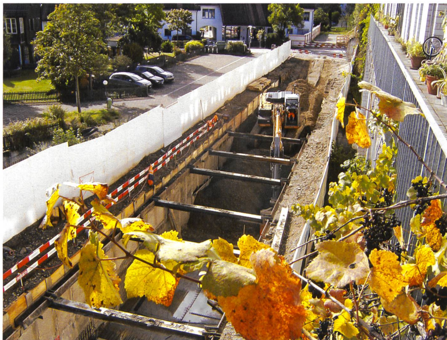
Bild 13. Baugrube Zuflusskanal, während den Aushubarbeiten.
