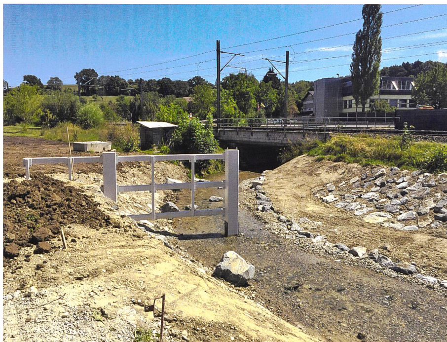
Bild 15. Unterer Schwemmholzrechen in der Linkskurve der Eulach, Blick gegen Fliessrichtung.
