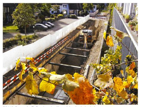
Bild 13. Baugrube Zuflusskanal, während den Aushubarbeiten.
