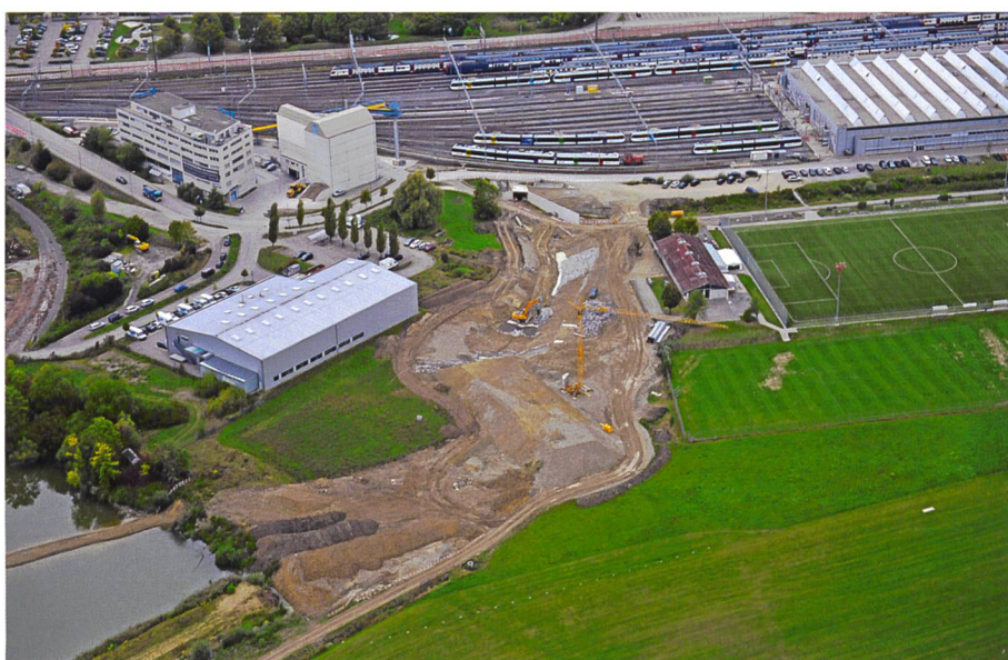
Bild 6. Vorbelastung im Bereich Durchlass während der Bauarbeiten im nachfolgenden Tosbecken, Blick Richtung Westen.
