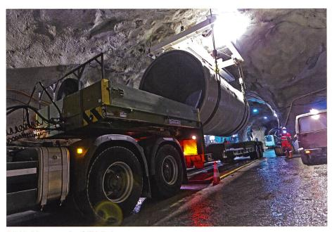
Bild 5. Montage der GFK-Rohre.
