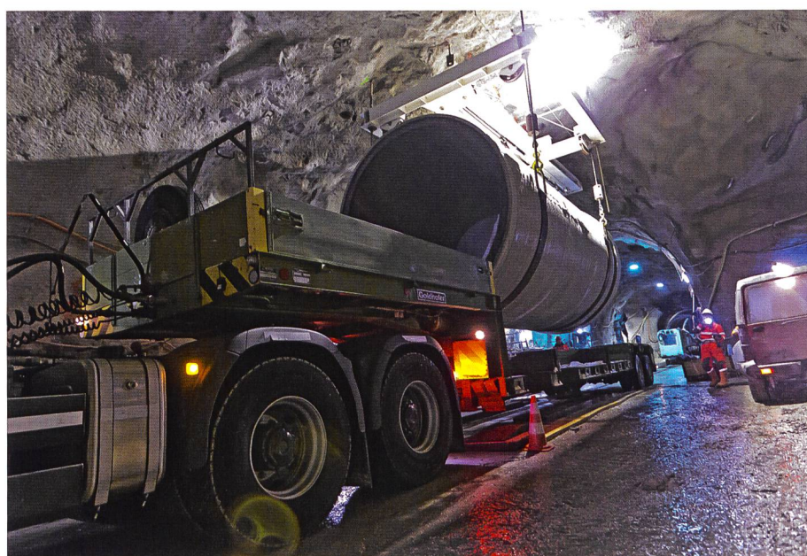
Bild 5. Montage der GFK-Rohre.
