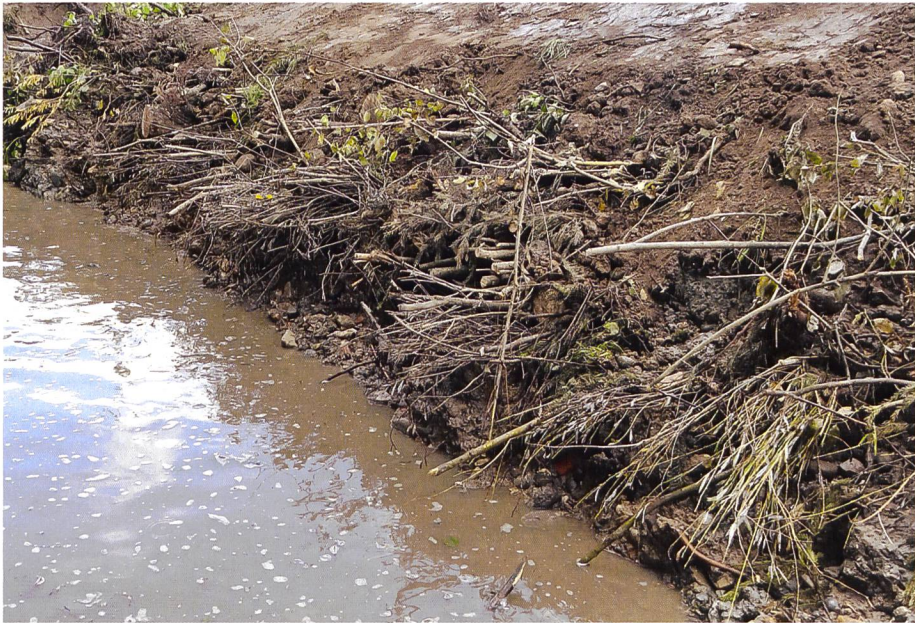
Bild 6. Die Böschung wird durch die vorstehenden Enden der Buschlagen lückenlos geschützt. Bis die Äste verrottet sind, hat die Durchwurzelung der Weiden die Festigung der Böschung übernommen.
