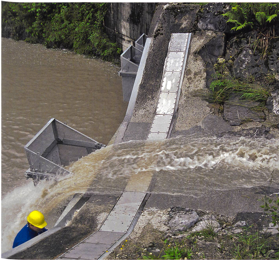
Bild 3. Geophon zur direkten Messung des Geschiebevolumens im Erlenbach (Foto: WSL).
