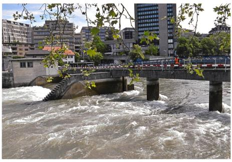
Bild 2. Das abgelegte und für zwei Stunden beinahe frei durchströmte Platzspitzwehr,  $230 \, \text{m}^3/\text{s}$  (Quelle AWEL).
